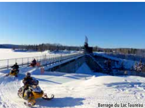
Barrage du Lac Taureau
